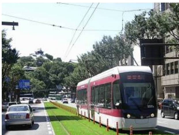
路面電車の軌道敷きの芝生化も進んでいます
