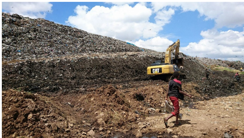
重機によりごみ山を整備
