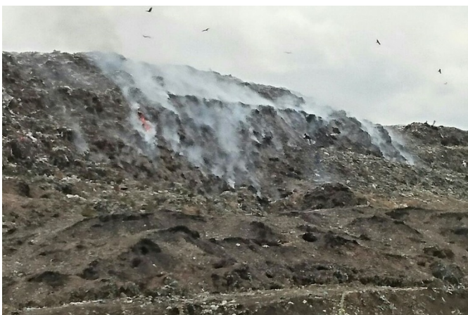
煙が立ち上る高さ50m、面積40haのごみ処分場
