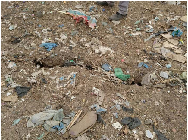
ごみ山崩壊の兆候であるいくつもの亀裂
