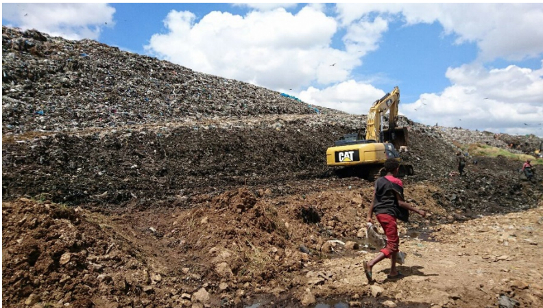
使用大型机械设备对垃圾山进行整修
